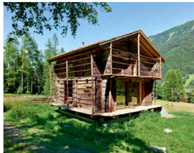
Une audacieuse transformation à Praz-de-Fort dans le val Ferret, signée Savioz Fabrizzi
